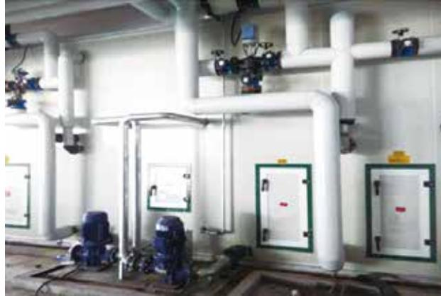
**空调、冷冻系统:** 空调机组是按工艺及环境要求送出合格、稳定的侧吹风，通过回风机从纺丝卷绕间(冬季)抽取回风进入空调器;同时引入适量新风混合后过滤，再经过喷淋加湿(夏季)经过冷冻系统冷却降温处理后，由送风机加压后通过中效过滤器净化处理，最后送入各纺丝位及车间。
